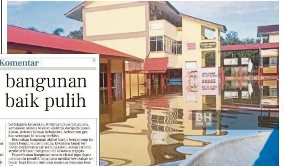
bangunan akibat banjir perlu dinilai secara cermat.
